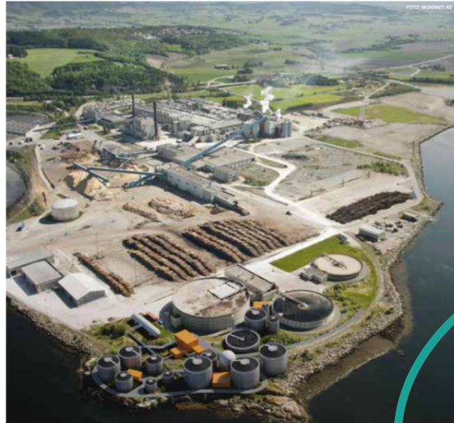
Biogassfabrikk. - Vi bygger nå verdens største produksjonsanlegg for flytende biogass-drivstoff i Trøndelag, og vi kommer til å utvide denne produksjonskapasiteten i årene som kommer, sier Håvard Wollan, administrerende direktør i Biokraft AS.
