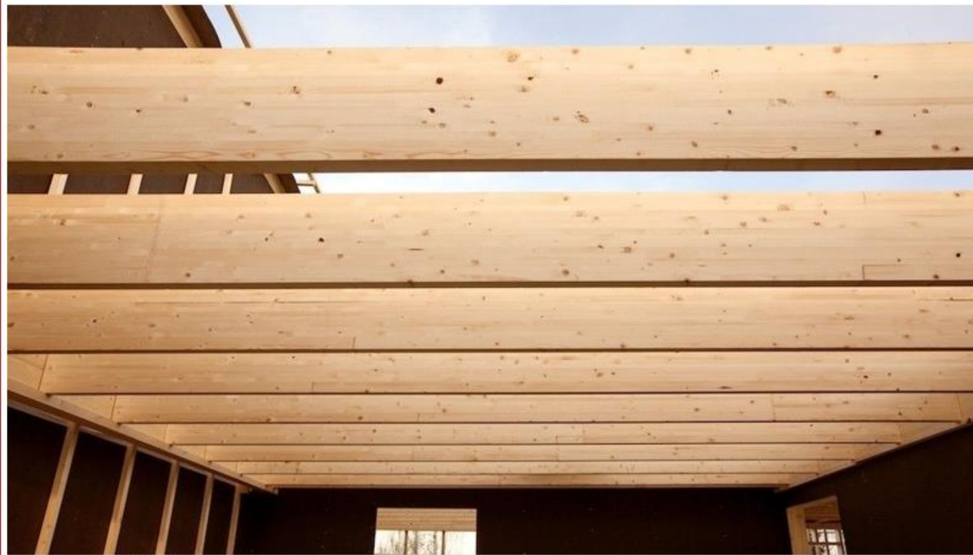
Illustrasjon av K-bjelke Plus. Foto: Kjeldstad
