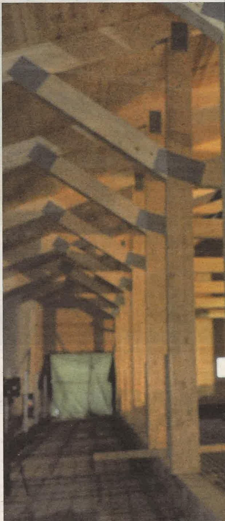
SATSER PÅ EGEN ARBEIDSPASS: Jonas Berg (27) satser mellom 6,5 og 7 millioner tonn i limtre og massivtre. Standerne i limtre har en dimensjon på 31 ganger
